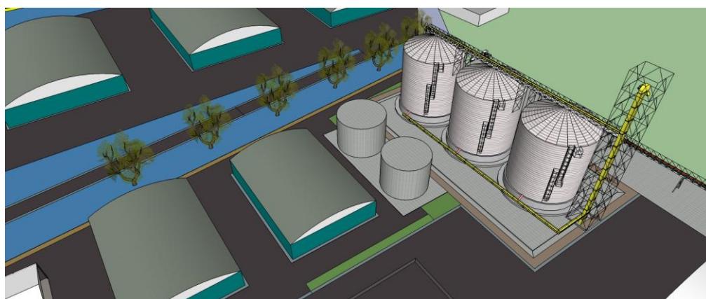
Figura 4.3 – Instalação de 02 silos de 18 mil toneladas cada.
